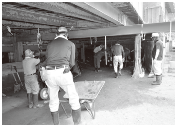
床下の泥出し
